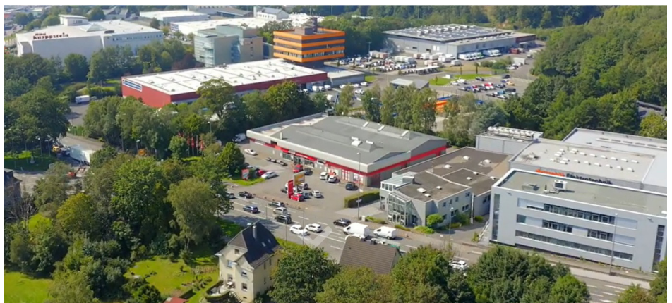
KFZ-Werkstatt A.T.U. Remscheid, Neuenkamper Str. 103, Mietfläche 1.700 qm, Grundstücksfläche 4.749 qm. A.T.U. Standorte erweisen sich als Standorte mit hervorragender Logistik mit Potenzial für den Einzelhandel.
