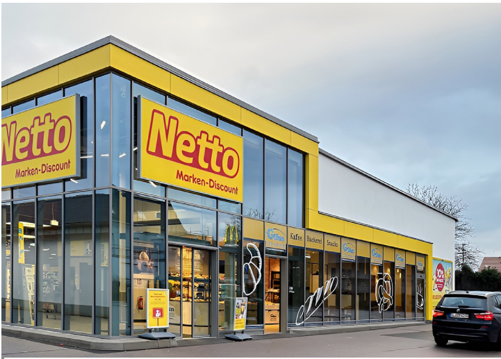
FIM-Renovierungsprojekt Netto-Markt Dillingen nach Brandvorfall. Flächenerweiterung und Integration eines Backshops durch erweiterten Aufbau.
