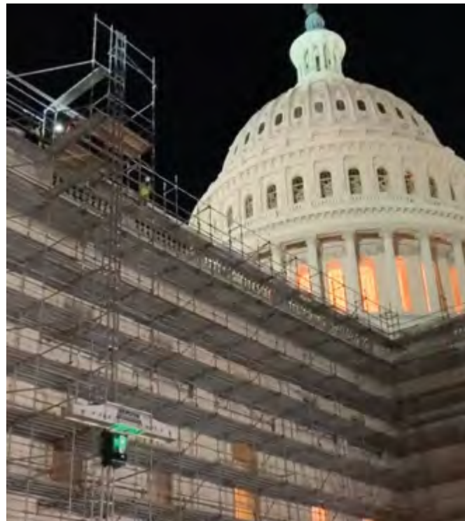
KEWAZOs Liftbot im Einsatz am Capitol in Washington
